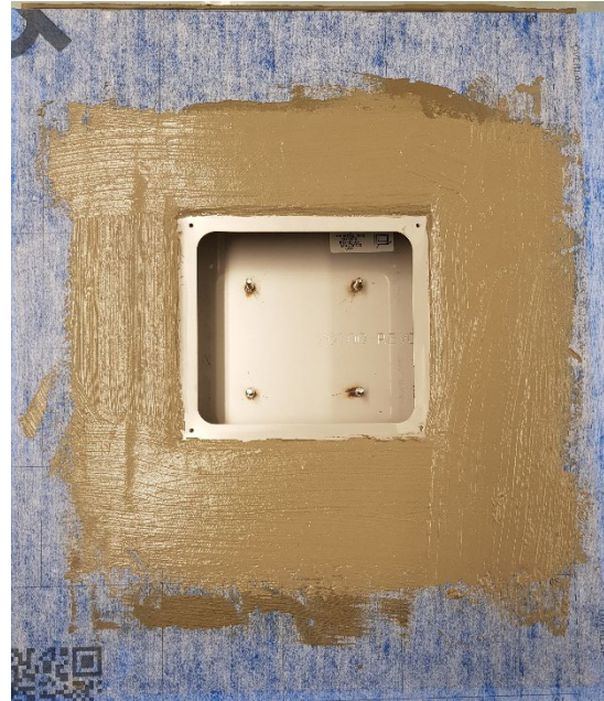
Image 4 – Webertec folie applied and the edges sealed with Webertec folie- och skarvlim
