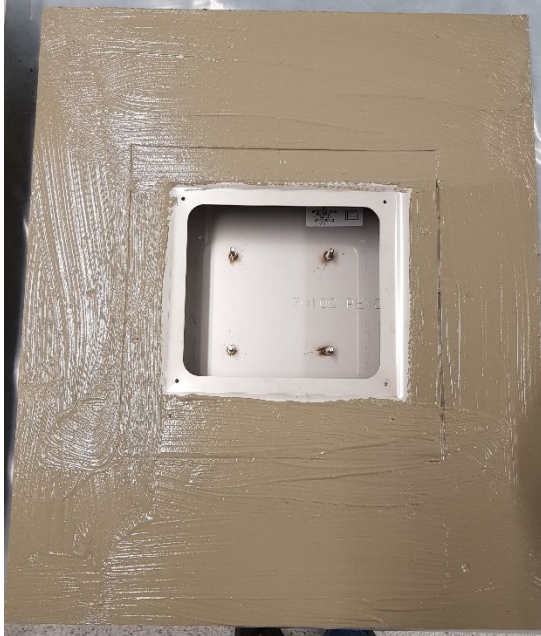
Image 3 – Webertec folie- och skarvlim applied on the front plate and on the plasterboard
